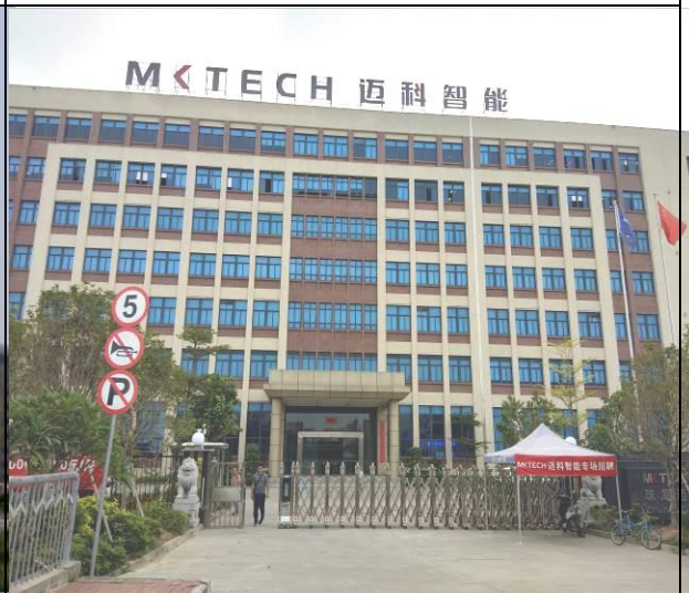
项目厂房（正面）
